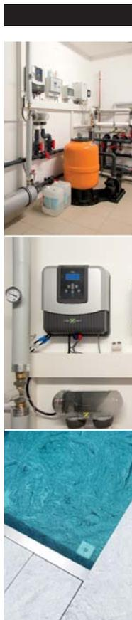
Der Technikraum wurde bei diesem Projekt in einem Zwischengeschoss geplant. Vom Keller aus wäre der Weg zum Schwimmbad zu weit und der statische Druck damit zu hoch gewesen. Hier arbeitet unter anderem die Elektrolyseanlage, die aus dem Salzwasser eine chlorhaltige Lösung gewinnt.
