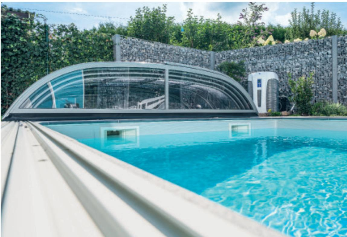
Aus der Poolperspektive: das Becken mit zwei Skimmern und der zurückgeschobenen Überdachung. Die Wärmepumpe im Hintergrund hält das Badewasser bei knapp 30 Grad Celsius.
